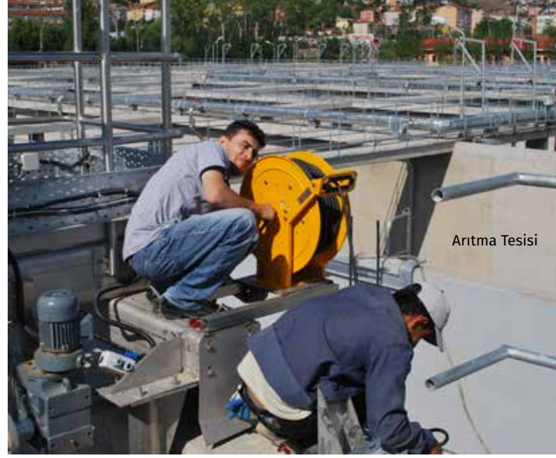
Vinçlerde Kullanılan Yağ ve Enerji Aktarım Tamburu
